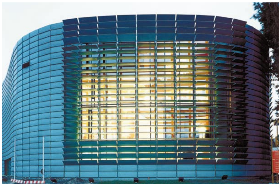
Väl tilltagna ljusinsläpp ger värme och ljus åt interiören.
