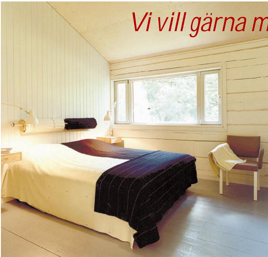
I sovrummet syns tydligt det massiva åtta tum tjocka virket i ytterväggen, oisolerat.
