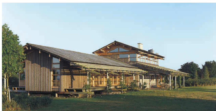
Utvändig järnvitriolbehandlad träpanel och rå linolja på fönstersnickerier och dörrar. Invändigt olika träpaneler. Golv av oljad ek respektive såpskurad furu. Taktäckning av lockbrädor av ek.
