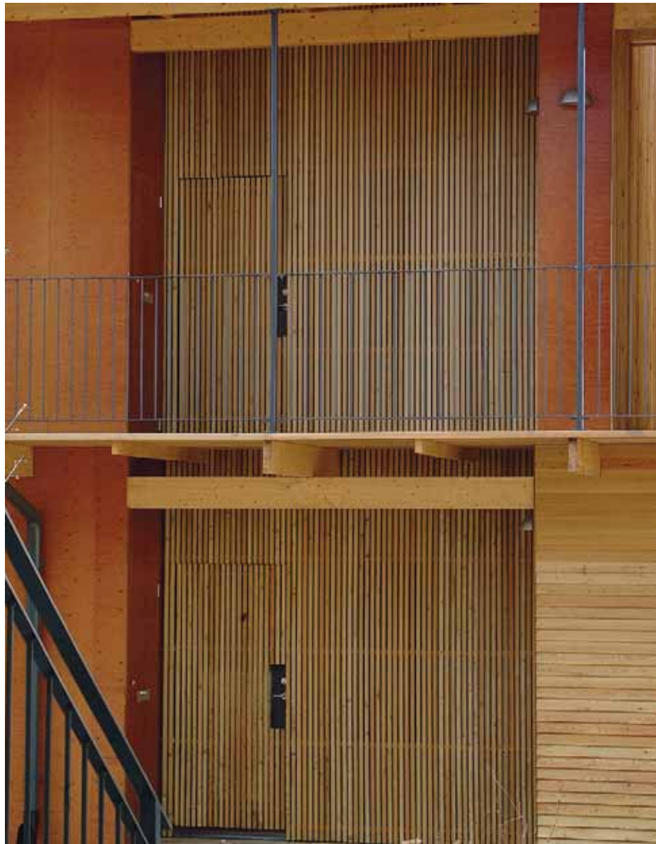
Fasaden i lärk har fjällpanelkaraktär.
