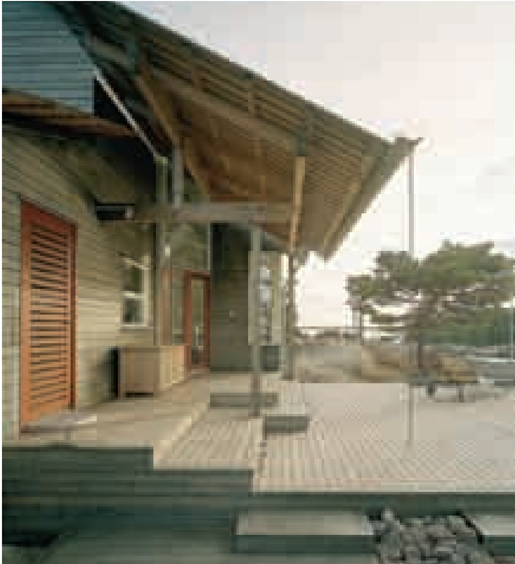
T.v.: Sjöboden är utförd i två olika golvnivåer anpassade till berghällarna. Närmast ligger den vedeldade bastun med utsikt över fjärden. Ovan: Ett stort rumsbildande skärmtak av kärnfura skyddar huvudbyggnadens entré.
