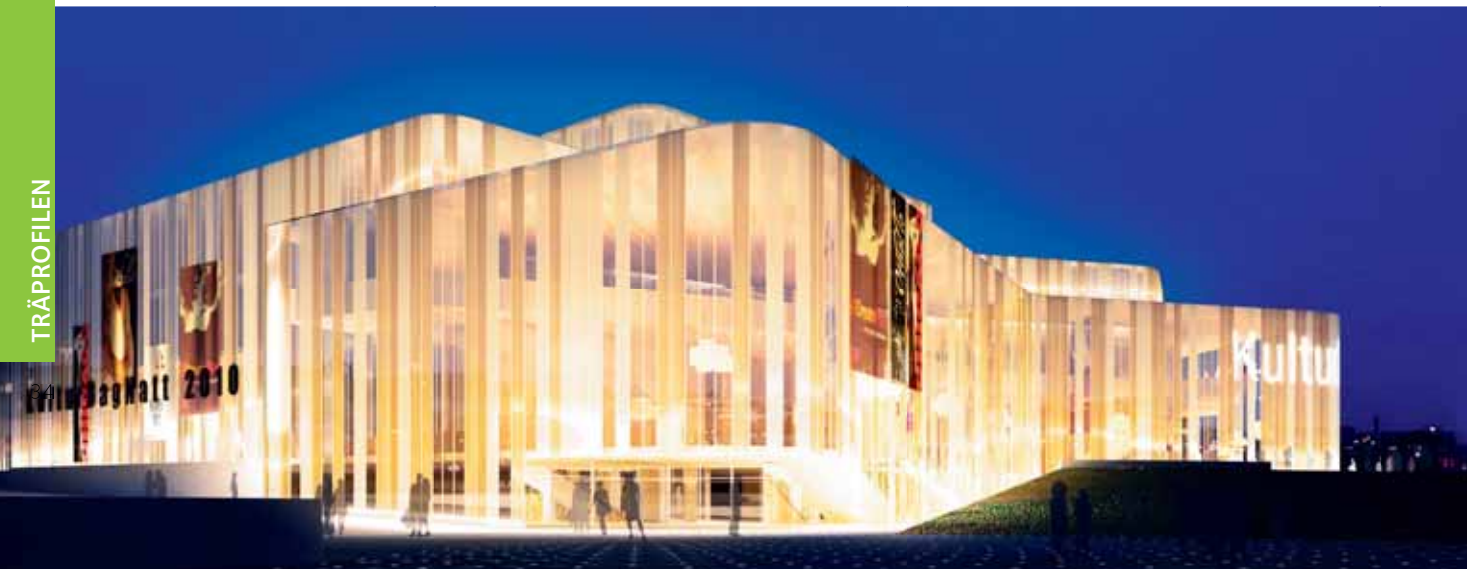
Smålands Musik och Teater: Arkitekt: Wingårdh Arkitektkontor AB. Adress: Södra Kajen, Jönköping. Beställare: Landstingsfastigheter i Jönköpings län. Yta: 12 700 kvm. Klart: Hösten, 2010
