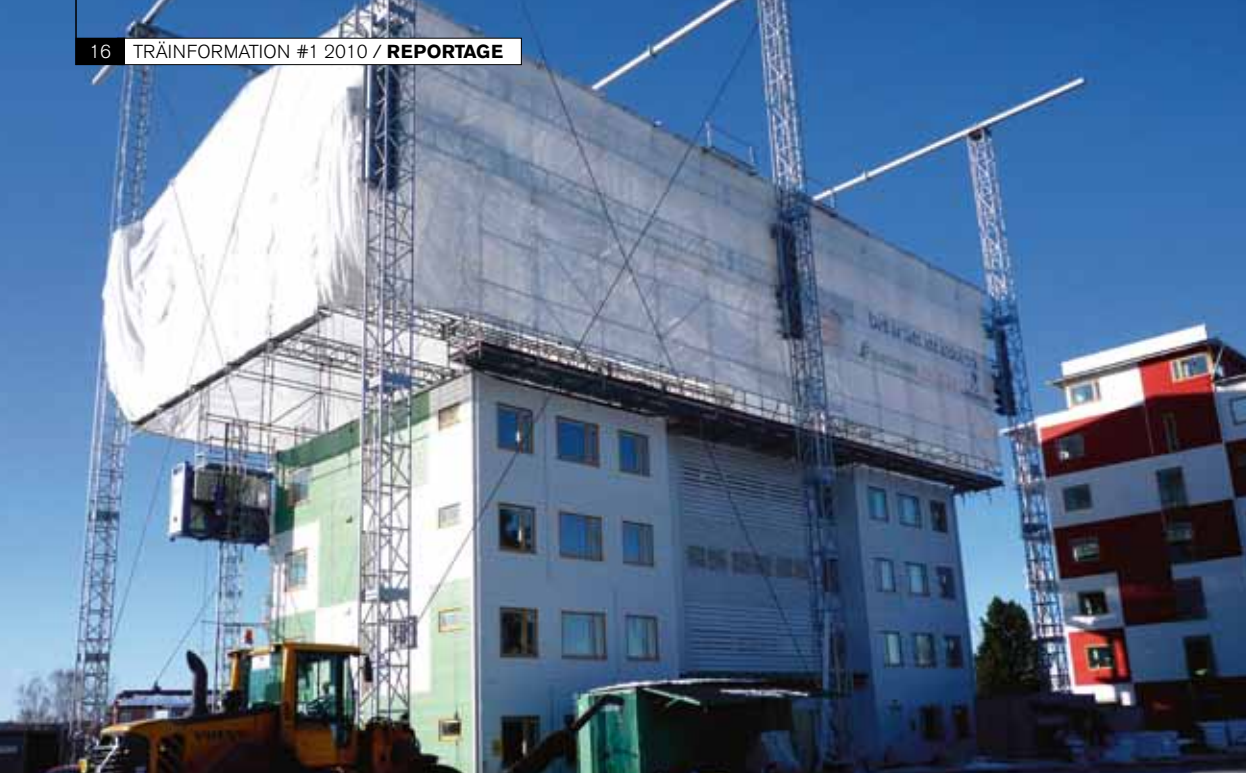
Ett väderskydd skyddar virket mot nederbörd och är ett nödvändigt led i att fuktsäkra processen från sågverk till byggarbetsplats.
