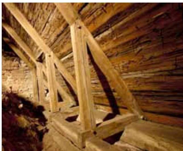
Exempel på knäbock med stickbjälke och två murrerremmar med förband av typen överkamning. Rogslösa kyrka i Östergötland.
