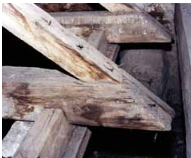
Exempel på en tidigmedeltida murrer som är urhuggen och med överkamningsförband med bindbjälken. Murrerremmen låg ursprungligen inmurad i murkrönet. Forshems kyrka i Västergötland.
