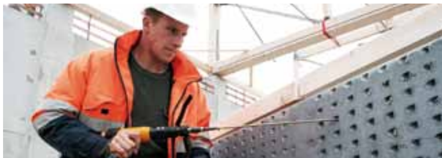
Professor Blass har uppmuntrat tillverkningen av skruvar i mycket stora dimensioner och utvecklat och infört denna typ av förband för överföring av höga laster.
